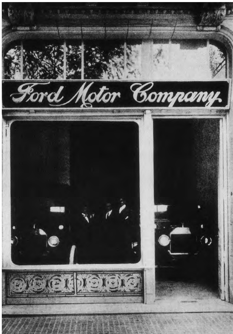
Planta Boca: Lavalle 1702. Segundo local de Ford Motor Company en Argentina. Fuente: Archivo Ford Motor Argentina
